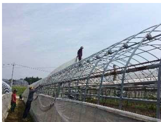
ビニール被覆作業
